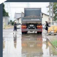
車輪の洗浄 粉塵防止
